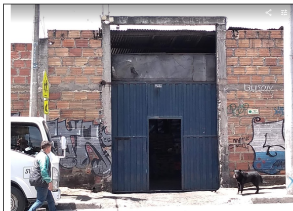
FOTO N°. 1 FACHADA DEL PREDIO.
