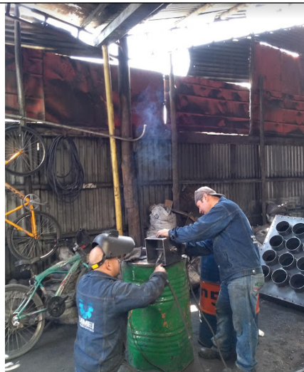
FOTO N°. 4 AREA DE SOLDADURA
